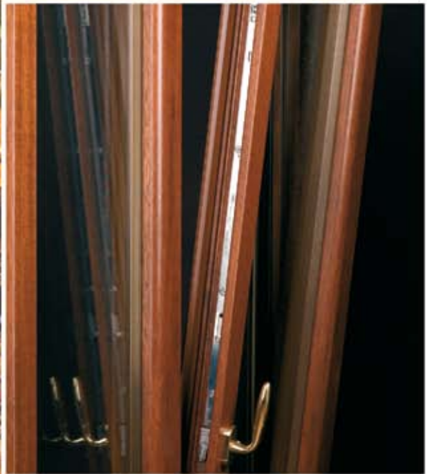
Apertura con anta a ribalta
