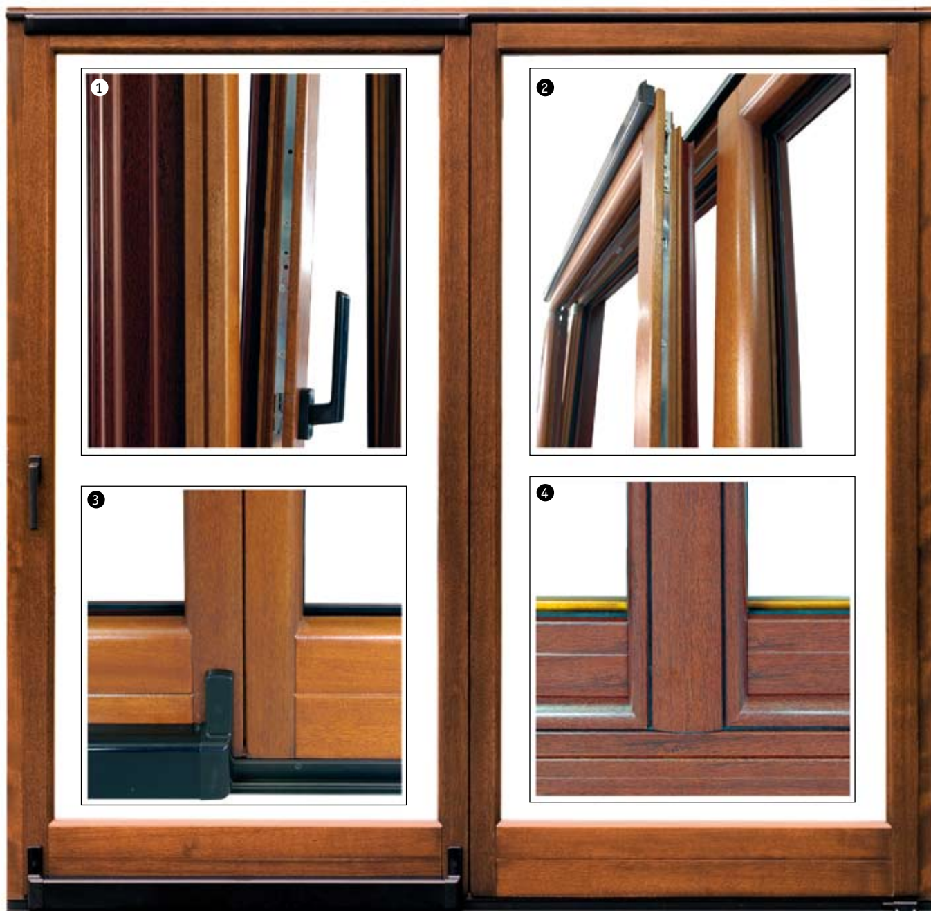
1. Particolare dello scorrevole con apertura a ribalta 3. Nodo centrale (vista interna)
