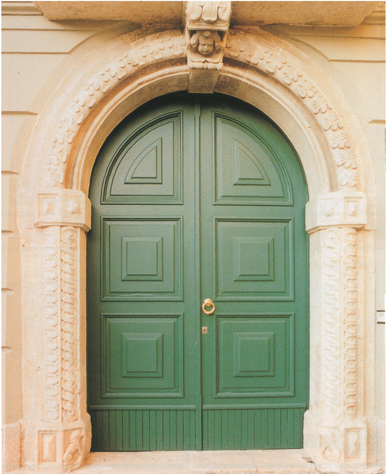
PORTONE AD ARCO, LACCATO, A DUE BATTENTI SIMMETRICI, CON RIQUADRI BUGNATI
