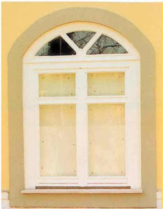
Infissi con scudo interno e cornice riportata nel riquadro vetri
